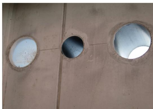
Pažnice HRD-FU po betonáži
